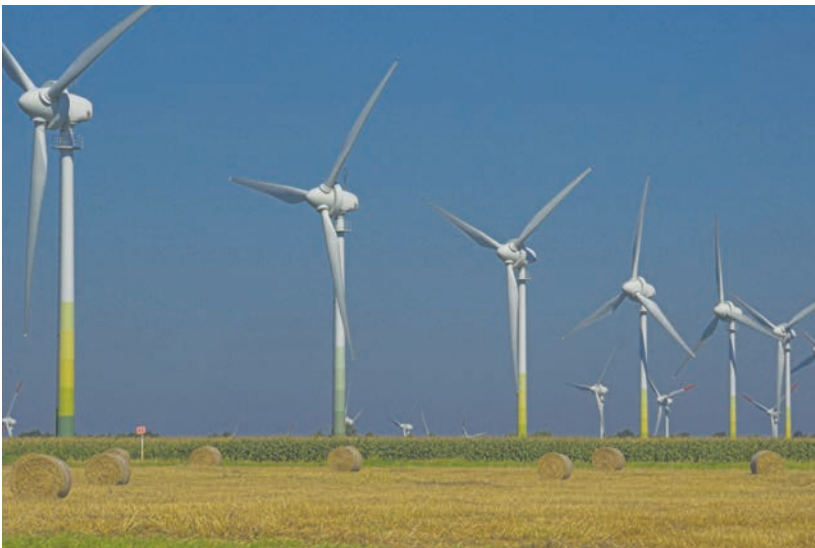
◆ Turbinas de viento en Alemania.
