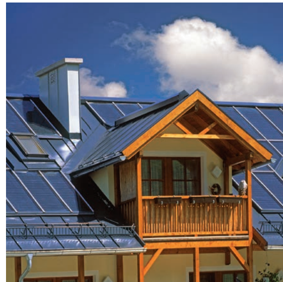
◆ Paneles solares en Viena, Austria.
