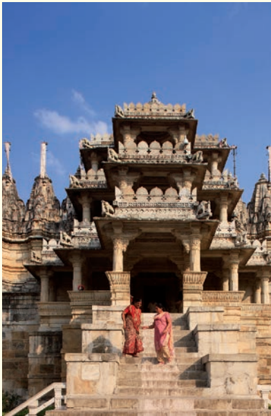
◆ Templo de Chaumukha, en Ranakpur, India.
