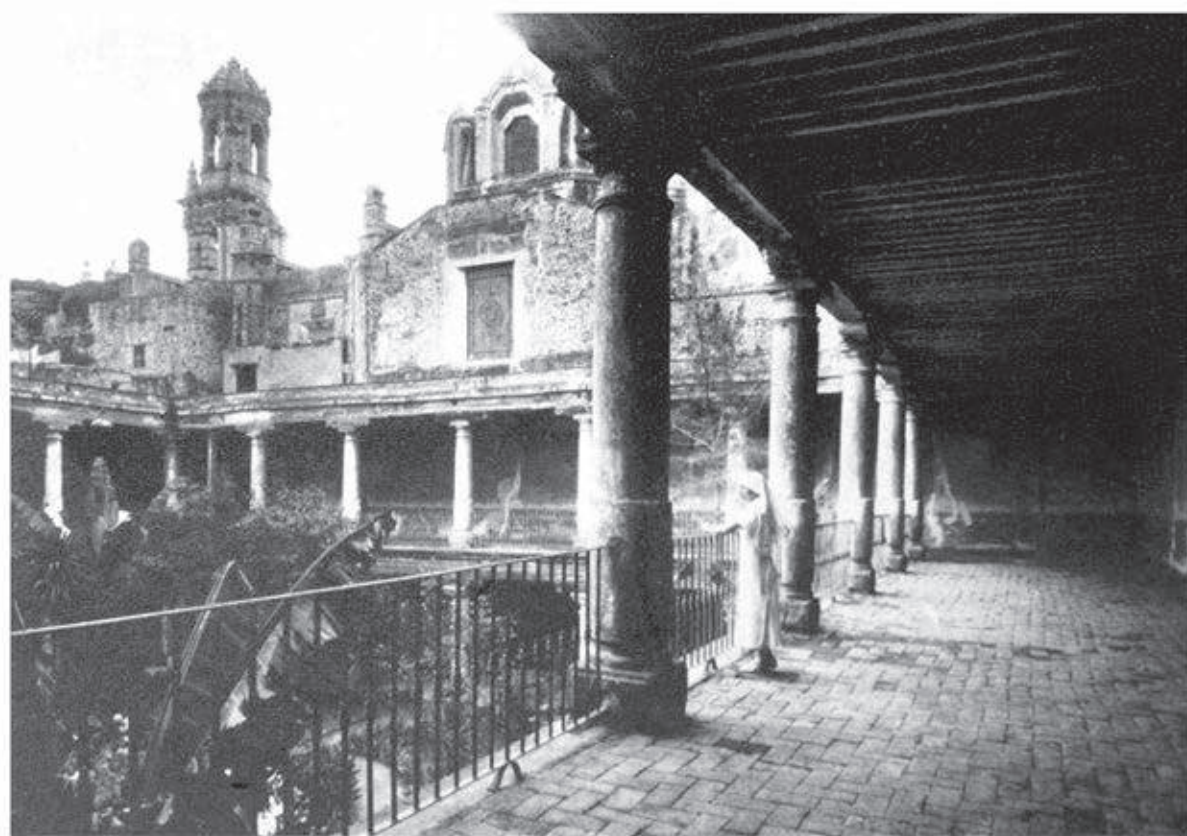
Hospital de San Juan de Dios, interior
